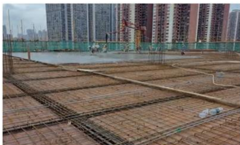
浇筑施工现场
